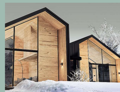
Наружная отделка зданий
